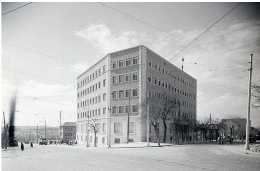
Figura 5. Fachada del Ambulatorio Hermanos Miralles
